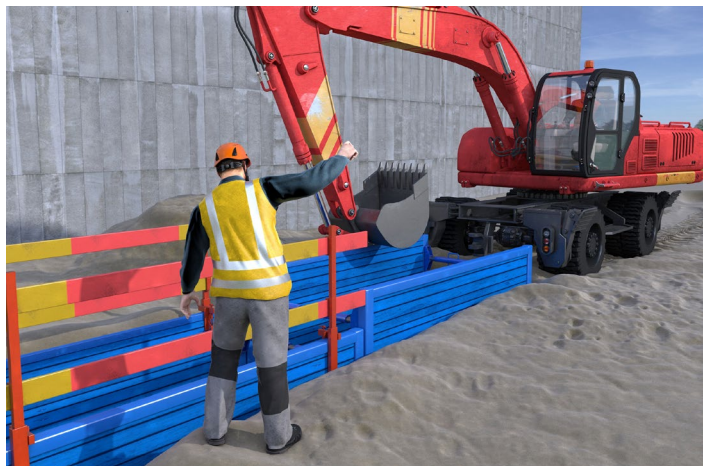
Abb. 25 Grabenverbaugeräte und Absturzsicherung
